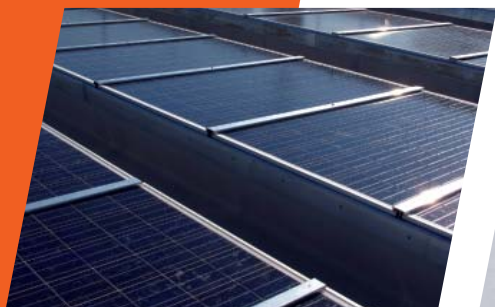
Système assurant partiellement ou totalement l'étanchéité de la toiture © GMPV-FFB - Dani Alu
