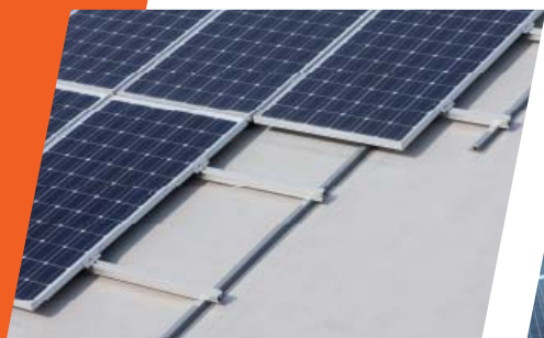
Système liaisonné à l'étanchéité © GMPV-FFB - Renolit
