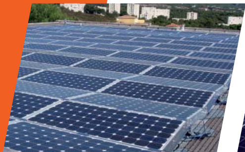
Système fixé sur dispositifs solitaires de la structure porteuse © GMPV-FFB - SMAC
