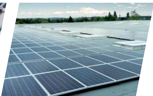
Système liaisonné à l'étanchéité © GMPV-FFB - Dome Solar
