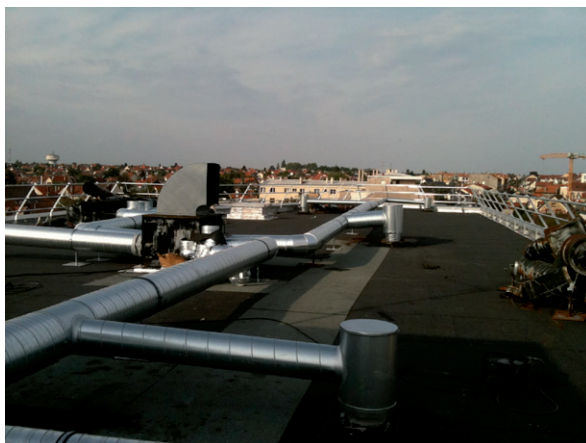
Installations de VMC en toiture terrasse
