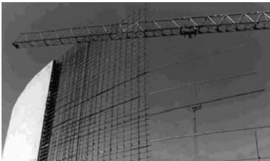
Structure avec armatures inox.
