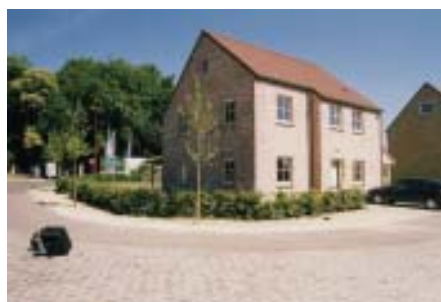
Fig. 4 Mesure de l'isolement acoustique des façades.
