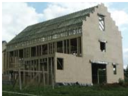
Fig. 1 La construction à ossature en bois : souvent desservie par une isolation acoustique médiocre.
