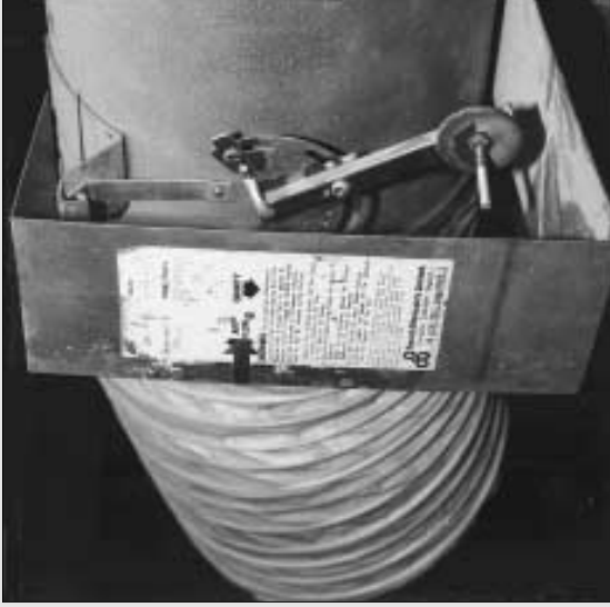
Clapet d'équilibrage avec manchette souple
