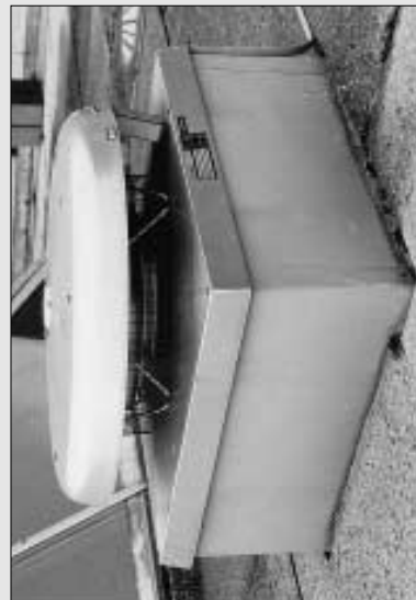
Ventilateur de toiture
