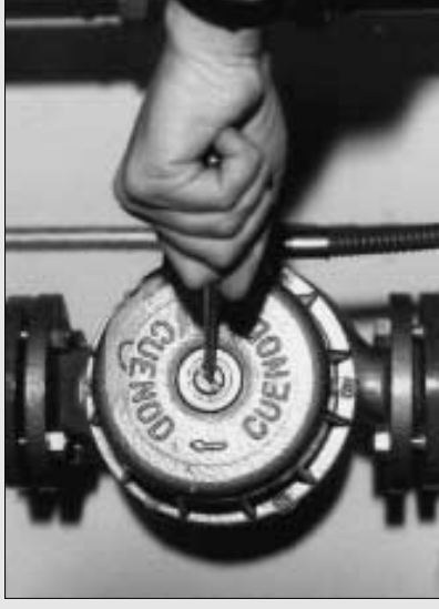
Déblocage du circulateur
