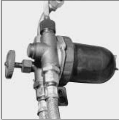
Filter à mazout
