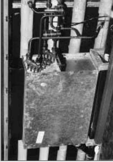
Ventilo-convecteur avec panneau de protection démonté
