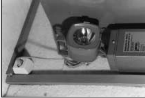
Eclairage de secours: vérifier le branchement de la prise
