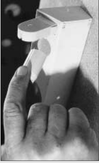
Remplacement du starter d'un tube fluorescent.
