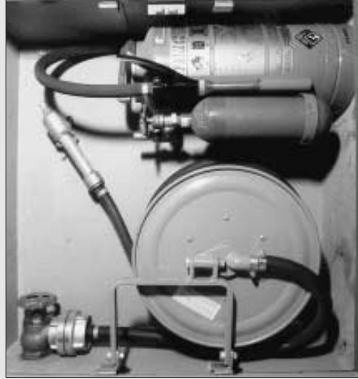
Poste incendie avec lance, extincteur aéromousse et bouteille d'air comprimé
