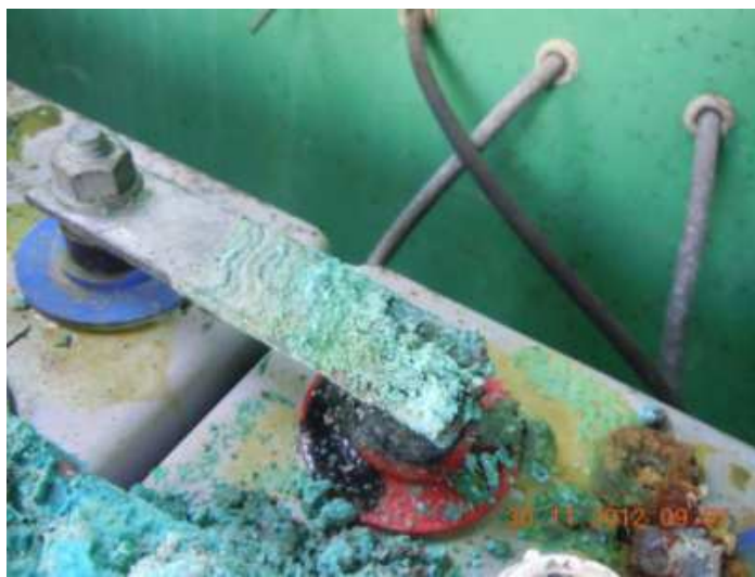
Figure 8 Par capillarité, le sulfate de plomb s'infiltré et remonte jusqu'aux bornes de la batterie
