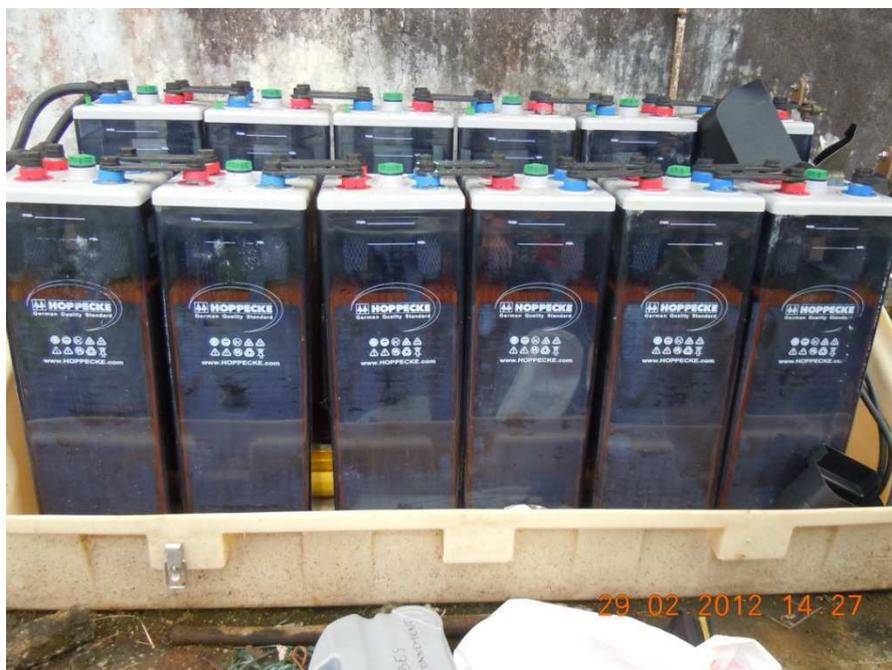
**Figure 2** Parc constitués de 12 éléments de batteries ouvertes de 2V (Capacité 800 Ah - Tension 24 V)
